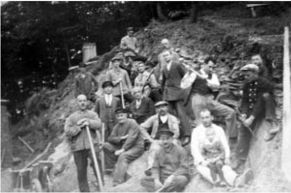
Männer der Gemeinde bei Ausschachtungsarbeiten, 1930
